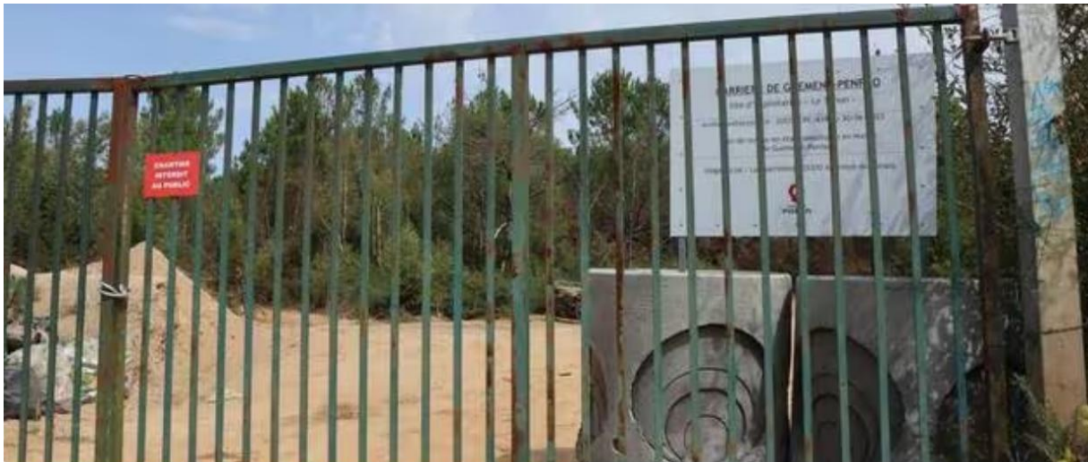
Au Tahun, la société Pigeon carrières rouvre la carrière de schiste et de grès à ciel ouvert. | OUEST-FRANCE
